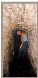
Souterrains en meulière
