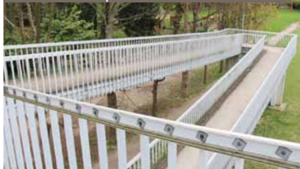
Les accès de la passerelle seront réhabilités
