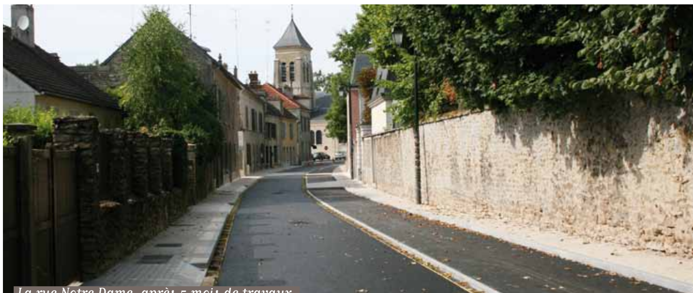
La rue Notre Dame, après 5 mois de travaux.
