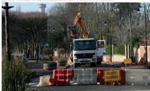
Les travaux d'assainissement sur l'avenue Chevalier
