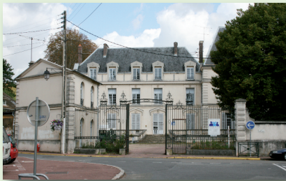
Château de l'ADAPT (vue de la rue de l'Eglise)
