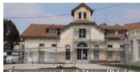
Les annexes du château (Rdc) vont accueillir un restaurant avec terrasse
