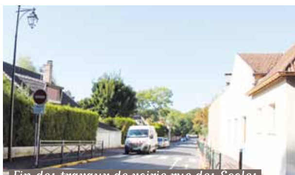
Fin des travaux de voirie rue des Ecoles
