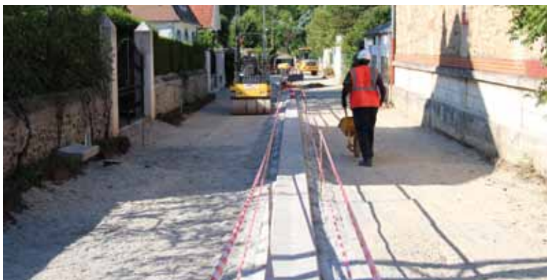
Réfection de la rue Saint Eugène (en cours)
