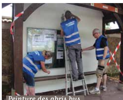
Peinture des abris bus.
