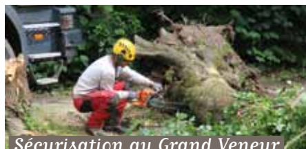
Sécurisation au Grand Veneur
