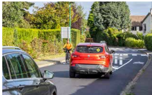
Dispositif de rétrécissement de la rue Mozart
